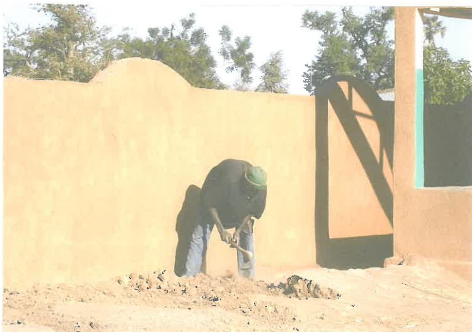
Restarbeiten am Rande der Mauer
